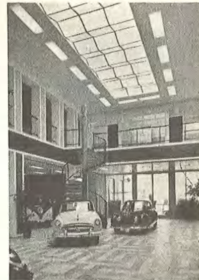
Akustisk varmeloft i et større udstillingslokale. Arkitekt: Gundelach Petersen. Ingeniør: Birch & Krogboe.
