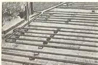
Niels Ebbesensvejns Skole, Frederiksberg tekniske Forvaltning. Rørslanger udlagt på forskalling inden indstøbning.
