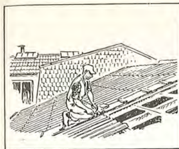
Oplægning af ETERNIT bølgeplader
