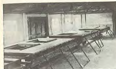
Støbehallen. Element i stålpladeform
