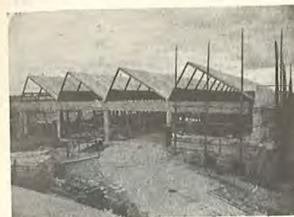
Shedtagskonstruktion.
