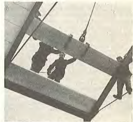
Oplægning af gasbetonplader
