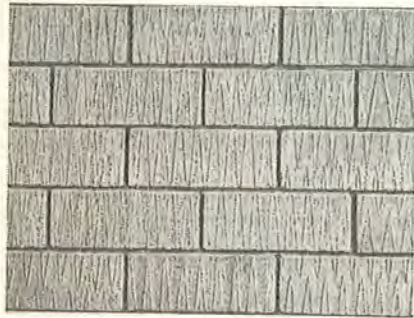
Gasbetonmurværk.
