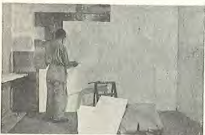
Denne væg er lydisoleret med tynd blyplade og lyd-dæmpet, samt varmeisoleret med Flamingo-plader og derefter pudset (Strandvejsparken, København). Man kan også tapetsere direkte på Flamingo, idet man først tapetserer med blødt bundpapir, f. eks. avis-papir.
