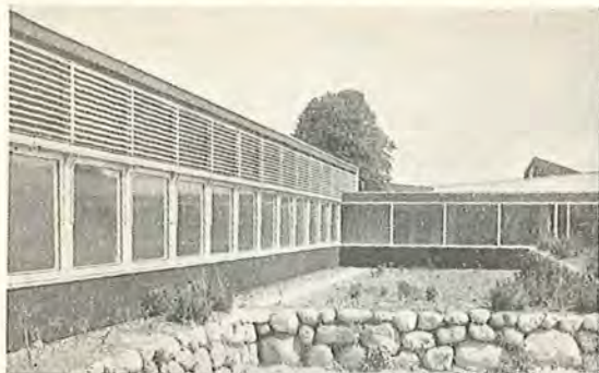
Buddinge skole tegnet af arkitekterne Eva og Niels Koppel M.A.A. Vinduene er øverst forsynet med lameller fremstillet i aluminium af special vejrbestandig legering for udvendigt brug.
